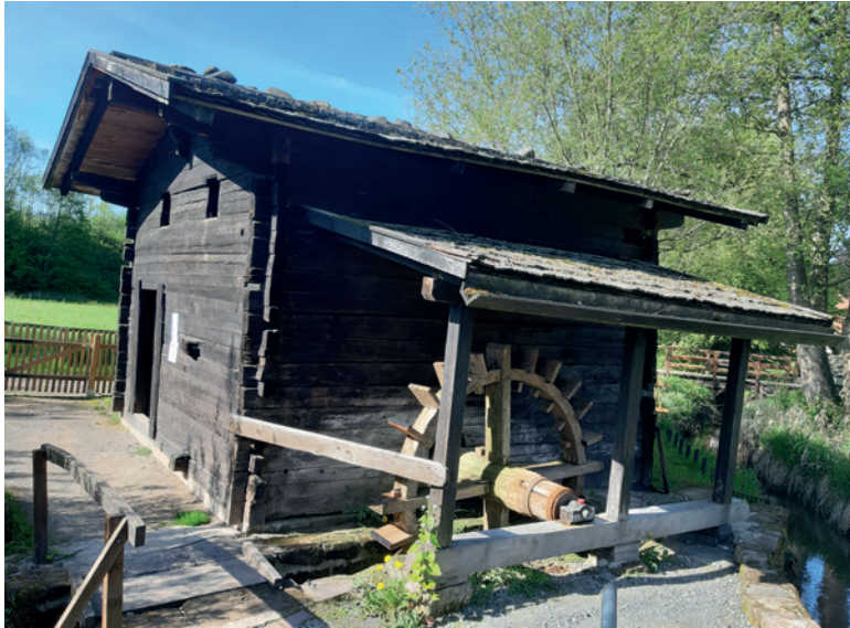
Abb. 2: Wassermühle, um 1600, am Standort Ebergötzen
