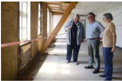
Besichtigung der Baustelle v.l.: . Dagmar Schlapeit-Beck, Ernst Böhme und Dinah Epperlein.Hinzmann
