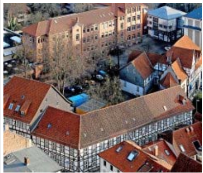
Harrt immer noch der Sanierung: das Städtische Museum im Jahr 2009.
