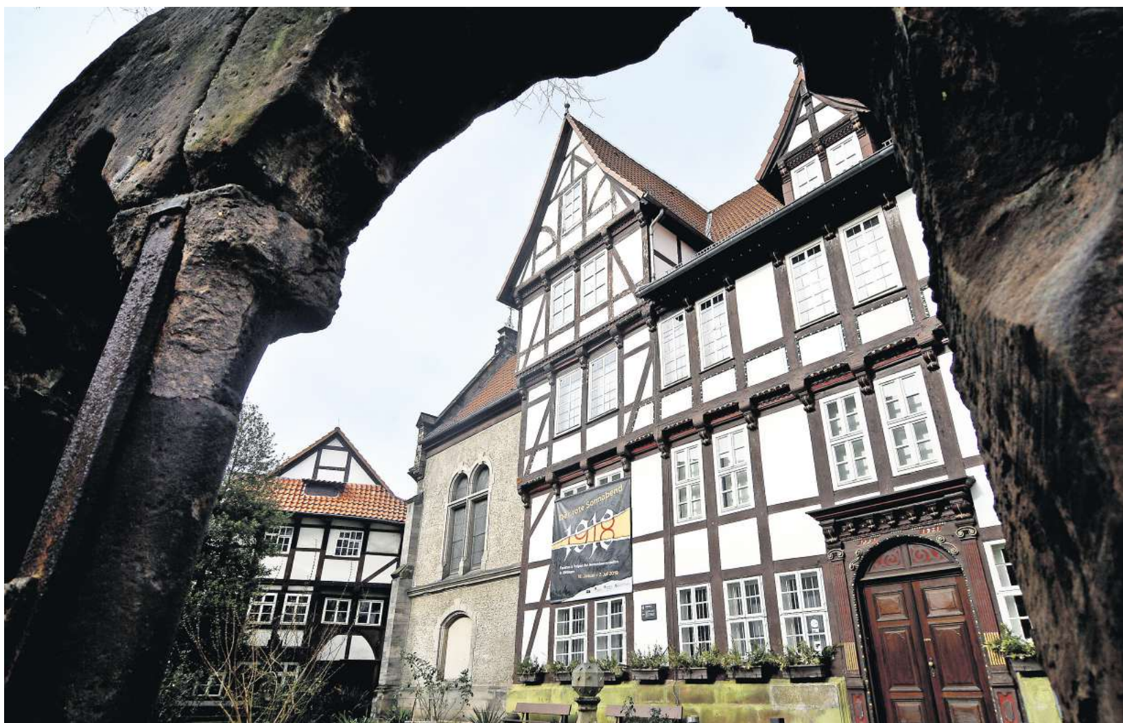
Der Haupteingang des Museums könnte auch nach der Sanierung erhalten bleiben.
